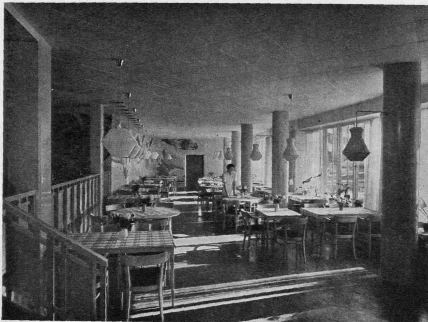
Kollektivhuset på Nockebyhov. Matsalen.
